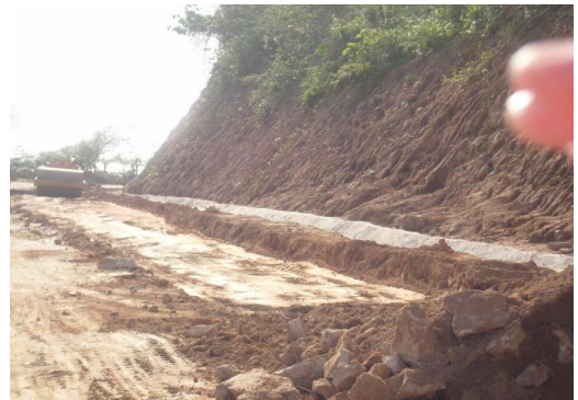
Hình 3.4: Hoạt động làm đường ở tiểu khu 62
